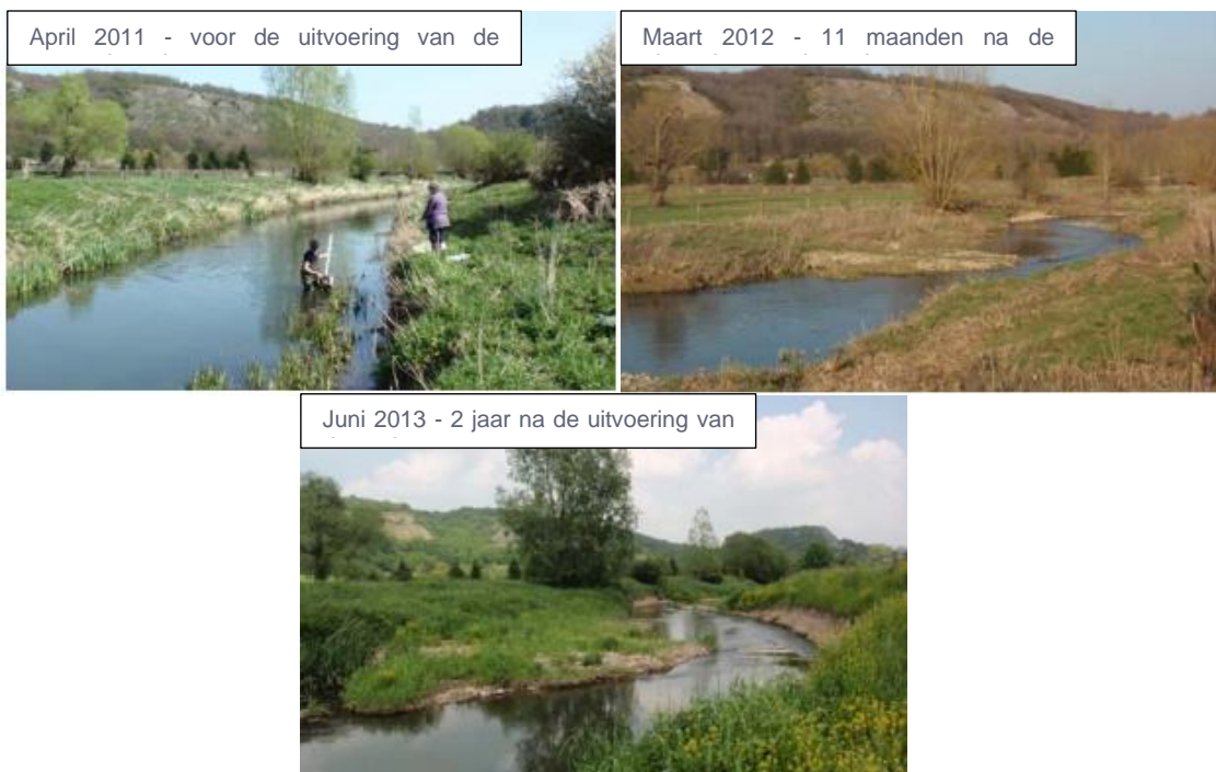
Figuur 36: Gehermeanderd deel van een sector van de Eau Blanche in Nismes (Bron: Guide technique WALPHY)
