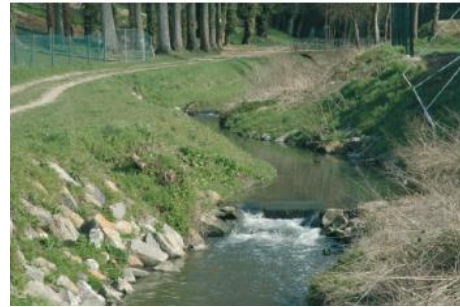
Figuur 45: Voorbeeld van een maatregel gericht op oeverbeheer: stortstenen (Bron : Guide technique WALPHY)
