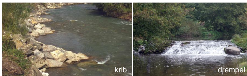
Figuur 42: Voorbeeld van kribben en drempel in een waterloop (Bron : épis en bloc (epfl) , continuité-ecologique.fr )
