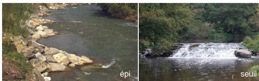
Figure 43 : Exemple d'épi et de seuil de cours d'eau (source : épis en bloc (epfl) , continuité-ecologique.fr )
