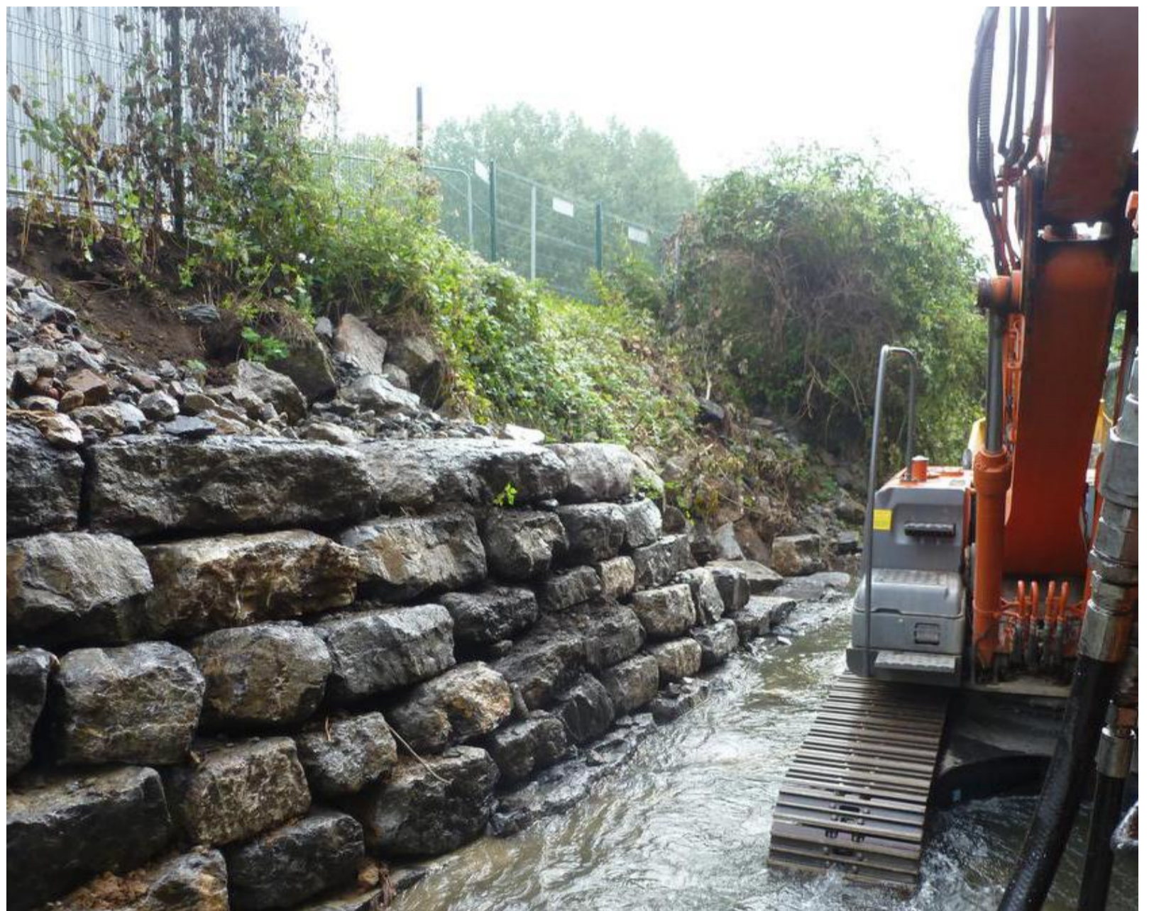
Rue de Zone à Mont-sur-Marchienne, près des aciers Grosjean, une pelleuse achève de consolider la berge dont l'effondrement menaçait un bâtiment. © D.R.
