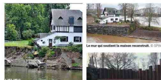
Le mur qui soutient la maison reconstruite. © SPW
