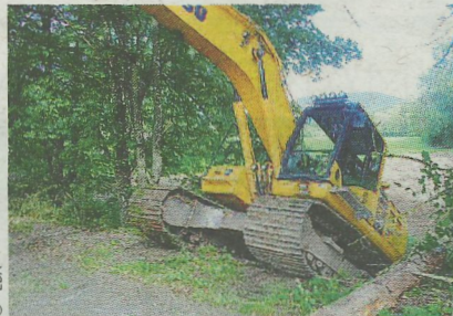
Les travaux de réfection le long de l'Aisne se révèlent très impressionnants.
